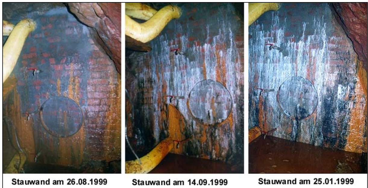
Abb. 18: Ansicht der vorderen Stauwand im Verlauf des Stauversuches vom 26.7.1999 bis zum 25.1.2000
