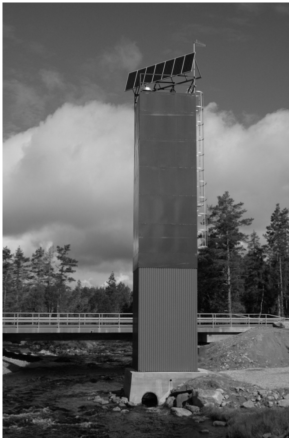
Abb. 7: Dosieranlage an einem Fließgewässer mit Solarpanel.
