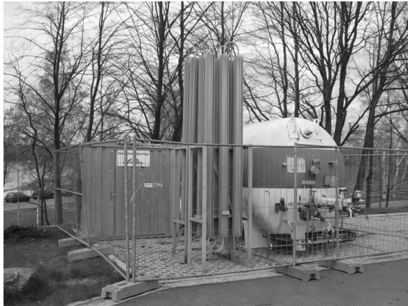
Abb. 3: Tankanlage inkl. Verdampfereinheit zur CO 2 -Versorgung .
