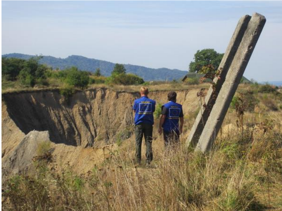
Abb. 1: EUCPT Experten vor Einsturzkrater der Salzmine No. 8
