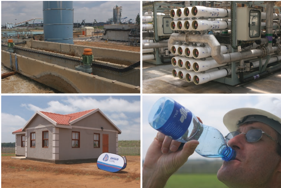
Abb. 7.7 Grubenwasserreinigungsanlage eMalaheni. Von links oben nach rechts unten: Vorreinigung (im Hintergrund links das Laugenbecken und rechts die Kohlenmine); Umkehrosmose; Gebäude aus Gips; in der Anlage hergestelltes Mineralwasser (Provinz Gauteng/Südafrika)
