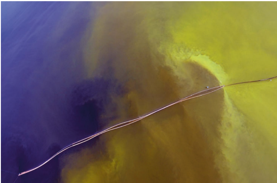
Abb. 6.4 Einspülen von gelöschtem Kalk in den Scheibe-See im November 2010 über Schlauchleitungen und eine landgestützte Zugabestation. (Bildbreite etwa 500 m; Foto: Peter Radke, LMBV)
