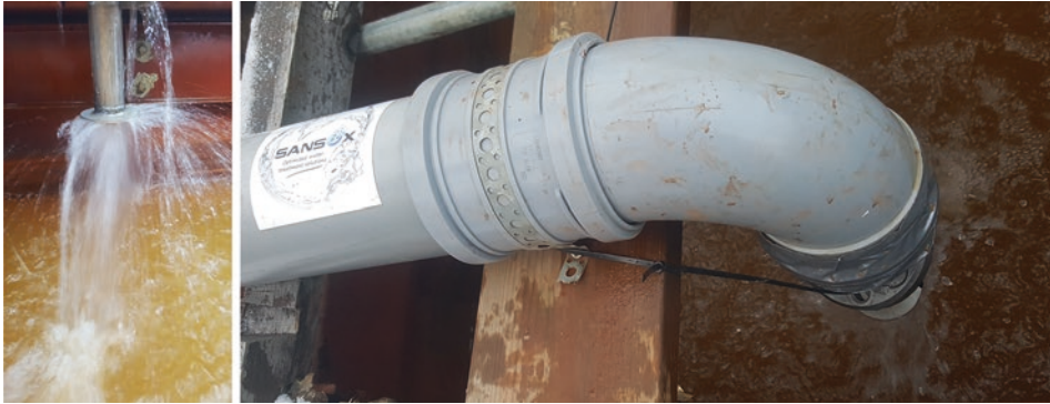
Abb. 4.25 OxTube im 90°-Winkel-Einbau am Vertikaldurchflussreaktor Metsämonttu. Die Sauerstoffsättigung im Grubenwasser kann dadurch von etwa 40 auf 60 % angehoben werden
