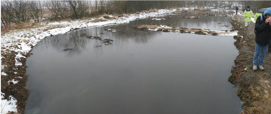
Abb. 4.10 Erstes europäisches anaerobes konstruiertes Feuchtgebiet Quaking Houses (County Durham, England, Vereinigtes Königreich). Pflanzenbewuchs fehlt, da der Schlamm nach 10 Jahren Betriebszeit ausgetauscht worden war
