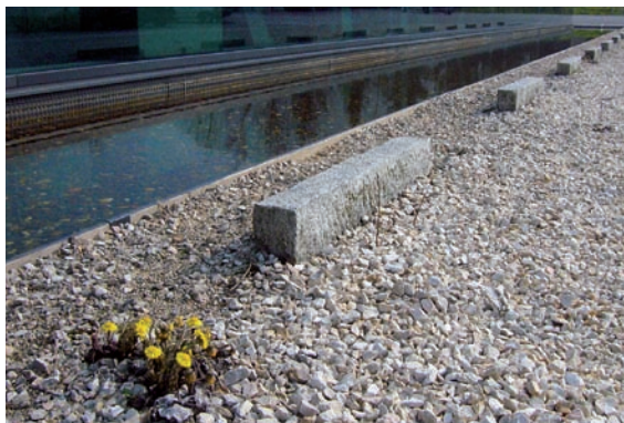
Dach- und Platzwassereinlauf in Sickermulden (Bauzustand), Schotterrasenparkfläche
