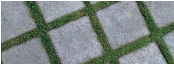
Pflastersteine mit Rasenfugen Sand oder Splitt Kies- oder Schottertragschicht Untergrund
