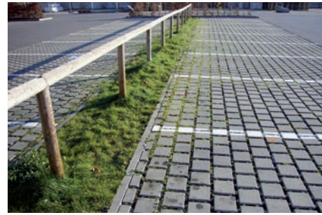
Pflastersteine mit Rasenfugen Sand oder Splitt Kies- oder Schottertragschicht Untergrund
