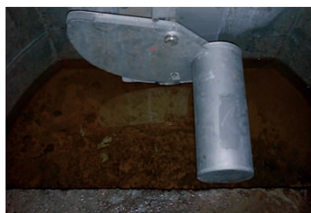
Drosselbohrung, Schema Rohrdrossel samt Notüberlauf, schwimmergesteuertes Drosselorgan
