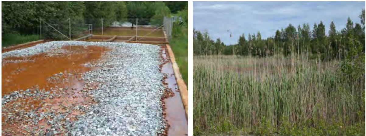
Kuva 26. Kotalahden suljetun kaivosalueen kalkkikiven puskurointiin perustuva vedenpuhdistamo (vasemmalla). Kasvilisuus on levittäytynyt hyvin rikastushiekan jätealueella muodostaen metallien sitoutumiseen soveltuvia kosteikkoja (oikealla), Leppävirta, Pohjois-Savo. (© A. Tornivaara, GTK)
