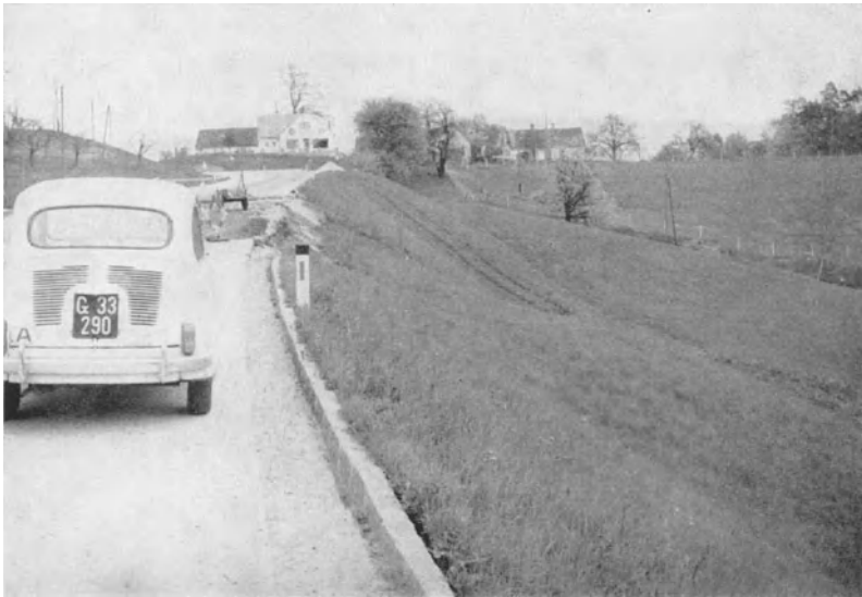
Abb. 161. Rutschungen entstehen durch starke Durchfeuchtung
