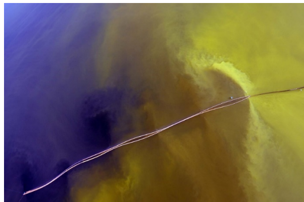
Abbildung 100: Einspülen von gelöschtem Kalk in den Scheibe-See im November 2010 über Schlauchleitungen und eine landgestützte Zugabestation (Bildbreite etwa 500 m; Foto: Peter Radke, LMBV).
