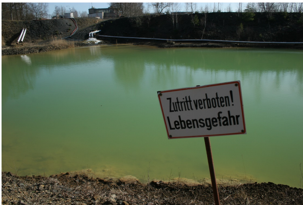
Abbildung 80: Absetzteich an der ehemaligen Grubenwasserreinigungsanlage Straßberg/Harz. Die Grünfärbung wird durch suspendierten Kalkstein hervorgerufen.
