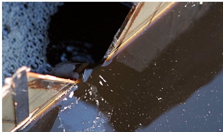
Abbildung 21: Falsch installiertes Messwehr an der ehemaligen IMPI-Pilotanlage Middleburg in der Provinz Gauteng, Südafrika. An der Wehrplatte fehlt die abgeschrägte, wasserseitige Abrisskante.
