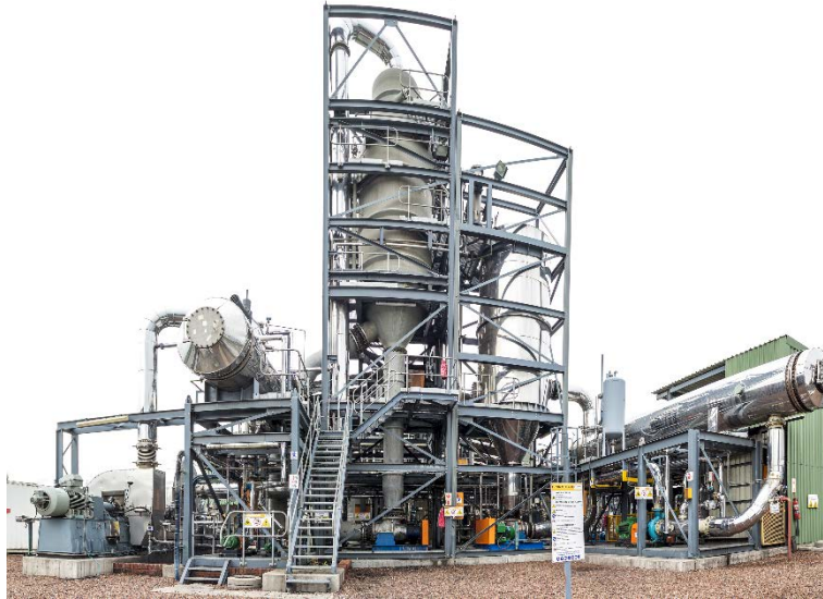
Abbildung 65: Proxa-Gefrierkristallisation am Tagebau der New Vaal Colliery der Anglo American Coal in Südafrika (Foto: Jochen Wolkersdorfer).
