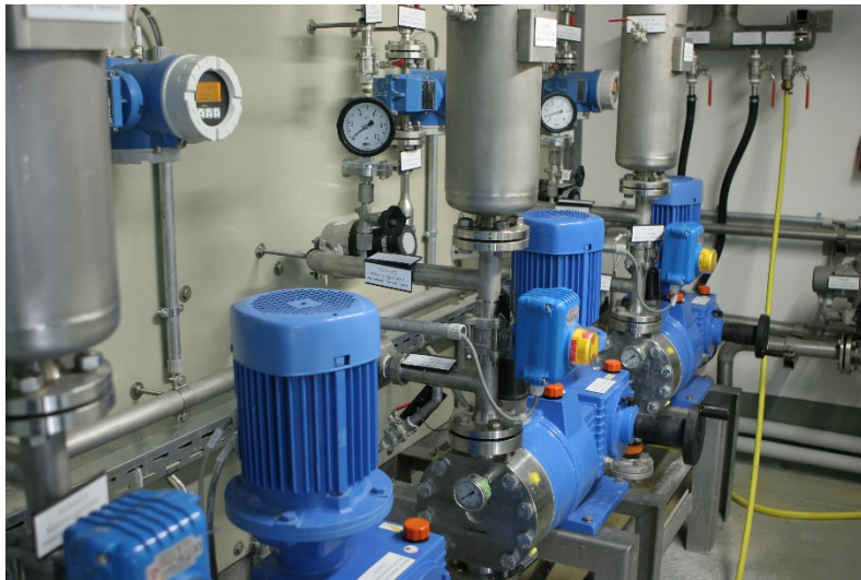
Abbildung 34: Pumpen für die Chemikalienzufuhr in einer aktiven Grubenwasserreinigungsanlage (Straßberg/Harz).
