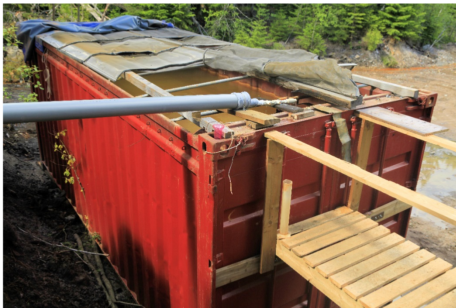
Abbildung 85: Containerisierter Vertikaldurchflussreaktor (VFR) am finnischen Polymetallbergwerk Metsämonttu mit Belüftung des Grubenwassers (Sansox Oy OxTube). Der Auslauf des Reaktors mit Messwehr für den Durchfluss befindet sich am hinteren Ende des 20'-Containers. Wasservolumen 24 m 3 .
