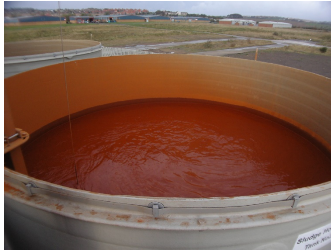
Abbildung 42: Schlammstammeltank der ehemaligen aktiven Grubenwasserreinigungsanlage Horden (County Durham, England).
