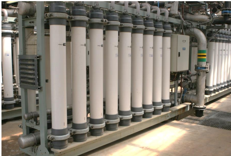
Abbildung 50: Ultrafiltrationseinheit der Grubenwasserreinigungsanlage eMalaheni in der Provinz Gauteng/Südafrika.
