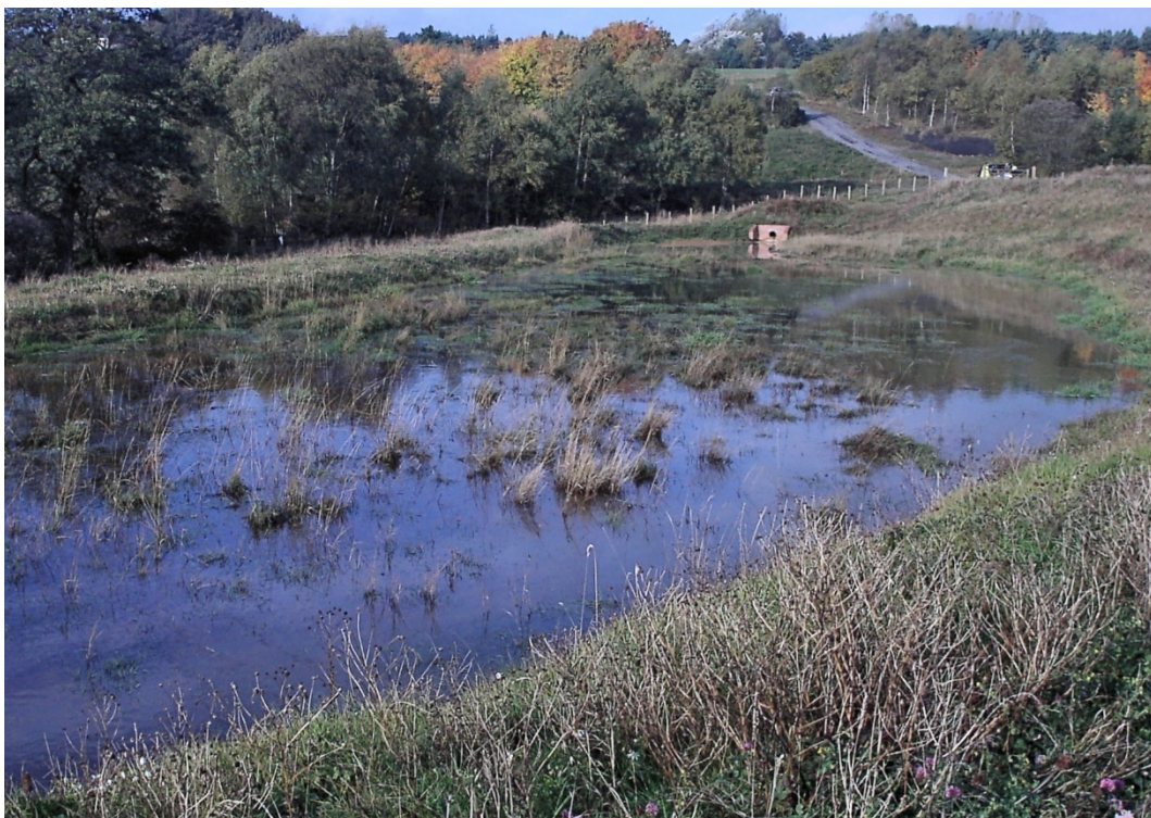
Abbildung 79: RAPS II am Standort Bowden Close, Landkreis Durham, England, Blickrichtung Westen. Auf dem Substrat aus Kalkstein und Pferdemist wachsen durch Sukzession typische Feuchtgebietspflanzen. Außerhalb des Bildes rechts befinden sich das RAPS I und links das konstruierte Feuchtgebiet.
