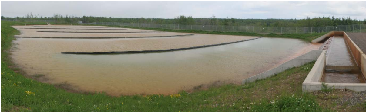
Abbildung 81: Absetzbecken der passiven Grubenwasserreinigungsanlage Neville Street, Neuschottland, Kanada, vor und nach der Installation von Leitfolien. Details in Wolkersdorfer (2011).
