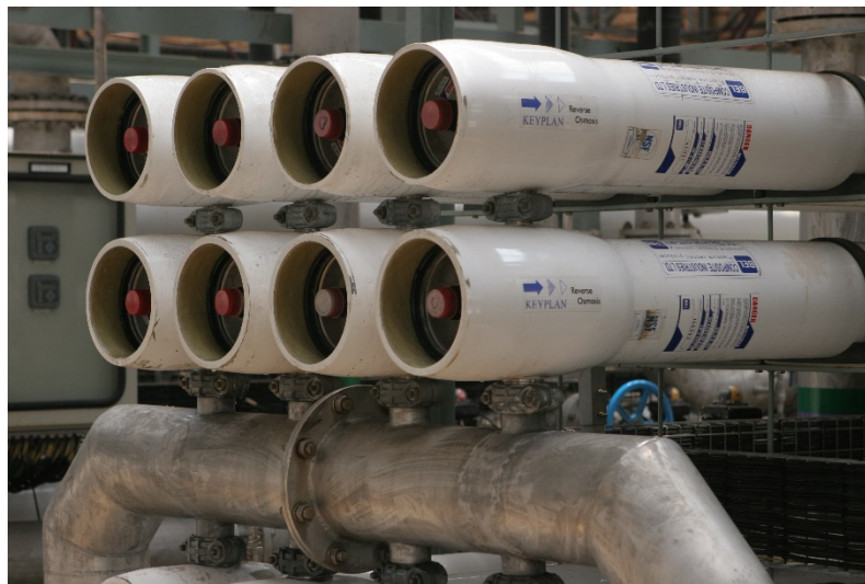
Abbildung 52: Umkehrosmoseeinheit der Grubenwasserreinigungsanlage eMalahleni in der Provinz Gauteng/Südafrika (vgl. Abbildung 113).
