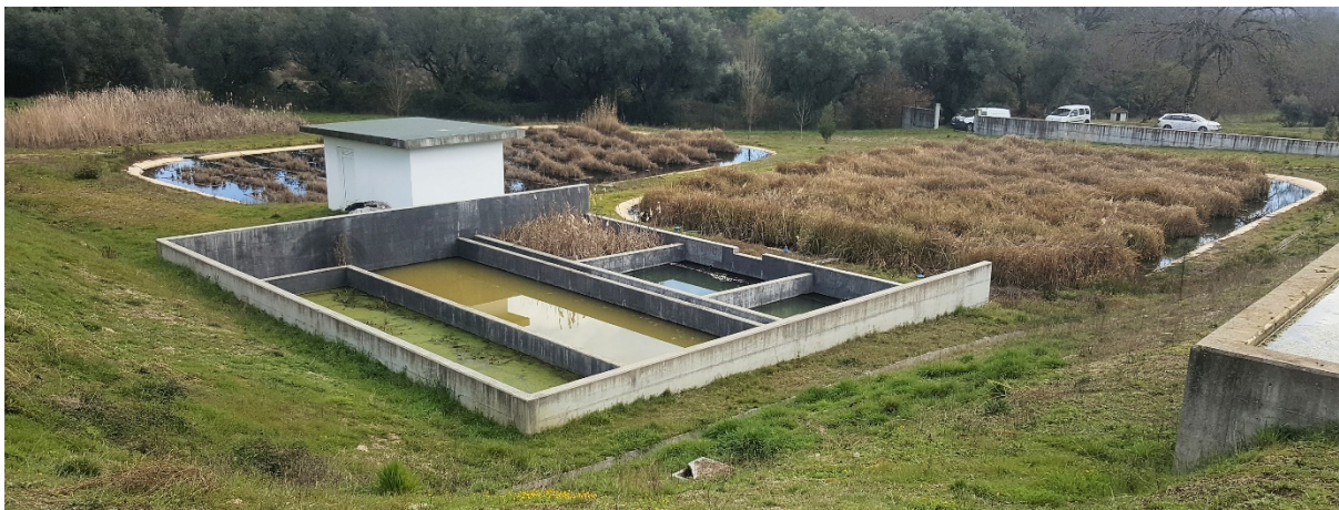
Abbildung 69: Absetz- und Makrophytenbecken sowie – heute nicht mehr notwendiges – Aktivkohlefilterbett und aerobes Feuchtgebiet am Uranbergwerk Urgeirica (Portugal). Das Grubenwasser ( Q \approx 90 \text{ L/min} ) fließt von rechts nach links, und der pH-Wert wird im Mittel von etwa 6 auf 8 angehoben. Im System werden Eisen, Uran und Radium zurückgehalten.
