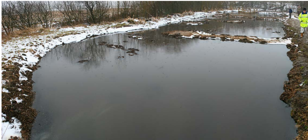
Abbildung 76: Erstes europäisches anaerobes konstruiertes Feuchtgebiet Quaking Houses (County Durham, England, Vereinigtes Königreich). Pflanzenbewuchs fehlt, da der Schlamm nach 10 Jahren Betriebszeit ausgetauscht worden war.
