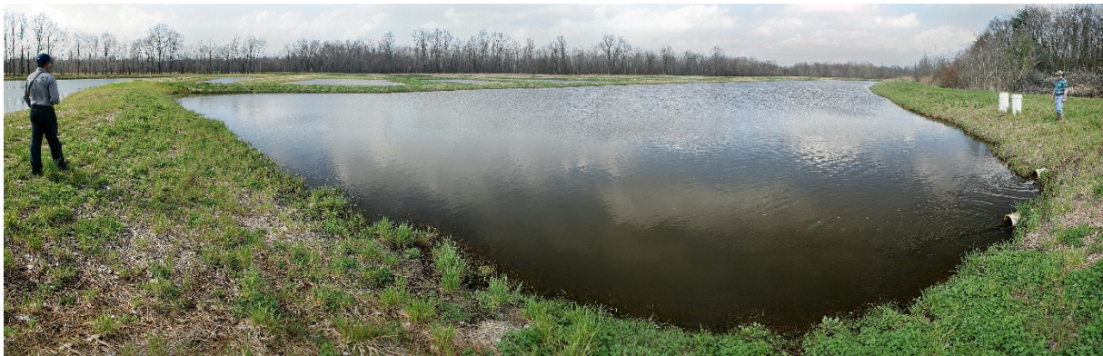
Abbildung 66: Teil der passiven Grubenwasserreinigungsanlage für die Abraumhalde an der Zeche Enos (Pike County, Indiana, USA). Die Funktionsweise des aeroben konstruierten Feuchtgebiets ist in Behum et al. (2008) beschrieben. Das Fotocomposite zeigt das Canal Aerobic Wetland im insgesamt 6,5 ha großen konstruierten Enos Ost Feuchtgebiet.
