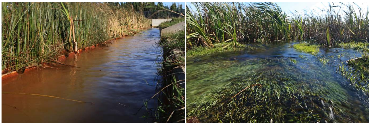
Abbildung 73: Zulauf (links) und Ablauf (rechts) des aeroben konstruierten Feuchtgebiets Neville Street (Kap-Breton-Insel, Neuschottland, Kanada). Das Wasser fließt verockert und metallreich in das konstruierte Feuchtgebiet (links) und verlässt es kristallklar und mit deutlich verminderter Metallfracht wieder (rechts).
