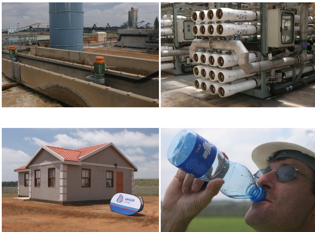
Abbildung 113: Grubenwasserreinigungsanlage eMalaheni. Von links oben nach rechts unten: Vorreinigung (im Hintergrund links das Laugenbecken und rechts die Kohlenmine); Umkehrosmose; Gebäude aus Gips; in der Anlage hergestelltes Mineralwasser (Provinz Gauteng/Südafrika).
