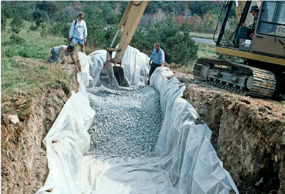
Abbildung 70: Anoxischer Carbonatkanal während der Konstruktionsphase. Im offenen Kanal befindet sich die Dichtungsfolie, und am hinteren Ende ist der Kanal bereits mit Kalkstein gefüllt (Foto: Jeff Skouson)
