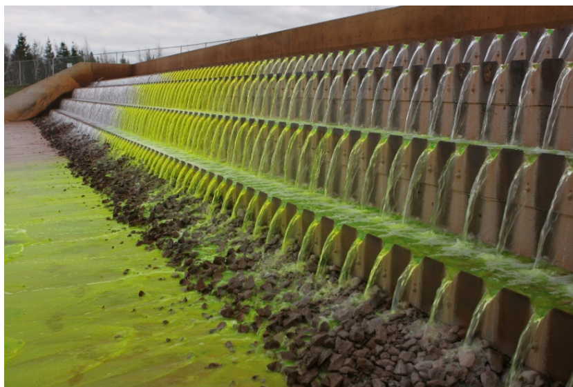
Abbildung 88: Oxidationskaskade der passiven Grubenwasserreinigungsanlage Neville Street, Neuschottland, Kanada, während eines Tracertests mit Uranin. Durchfluss etwa 1 \text{ m}^3 \text{ s}^{-1} ; Höhe der einzelnen Kaskadenstufen etwa 0,6 m.
