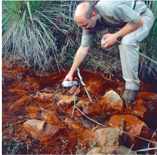
Abbildung 72: Ehemaliger offener Carbonatkanal an der Mina de Campanema/Minas Gerais in Brasilien. Die Verockerung der Kalksteine ist deutlich zu sehen.
