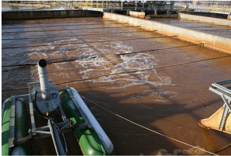
Abbildung 39: Belüftung von Grubenwasser in einer Dünnschlammanlage (Grubenwasserreinigungsanlage Schwarze Pumpe, Lausitz).
