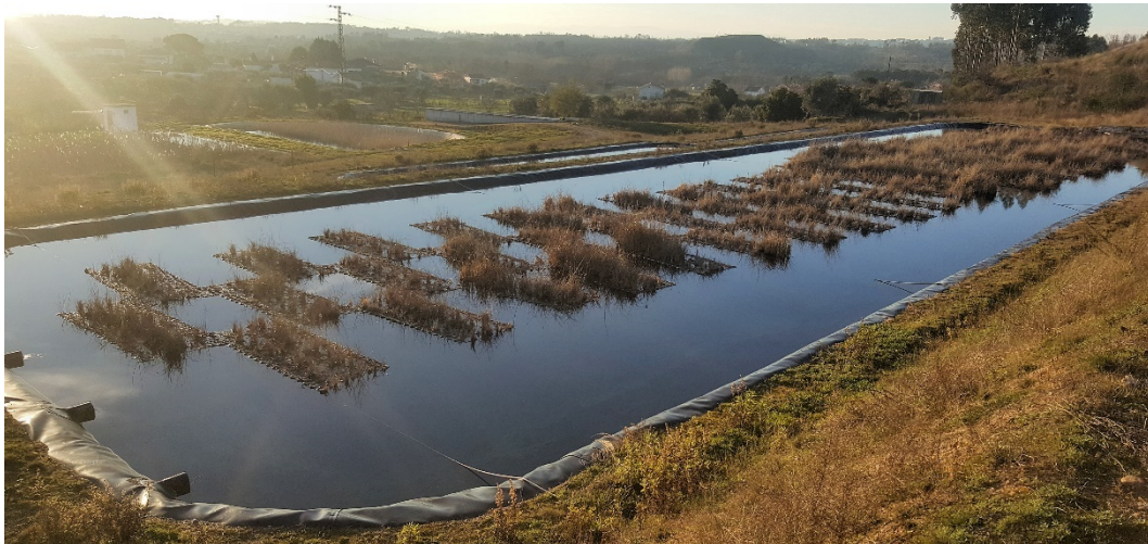
Abbildung 91: Makrophytenbecken eines ARUM-Systems am ehemaligen Uranbergwerk Cunha Baixa (Portugal). Im System werden Eisen, Uran und Radium zurückgehalten.
