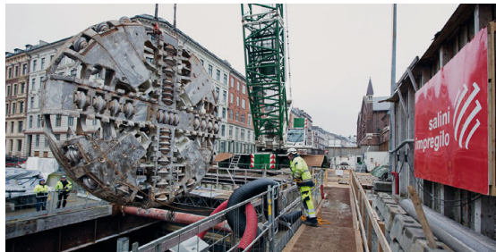
Bild 1: EPB-TBM-Vortrieb der Tunnelröhren
