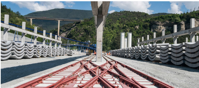
Bild 3: Tübbinglager Quelle: BBT SE
