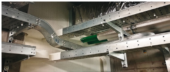
Bild 3: Installationssysteme für Medienleitungen zur Ver- und Entsorgung mit Strom und Wasser sowie Be- und Entlüftung
