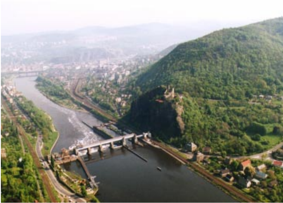
Abb. 2.7: Wehr Strekov mit Burg Schreckenstein bei Ústí nad Labem (tschechische Elbe-km 40), letzte Staustufe im tschechischen Elbabschnitt
