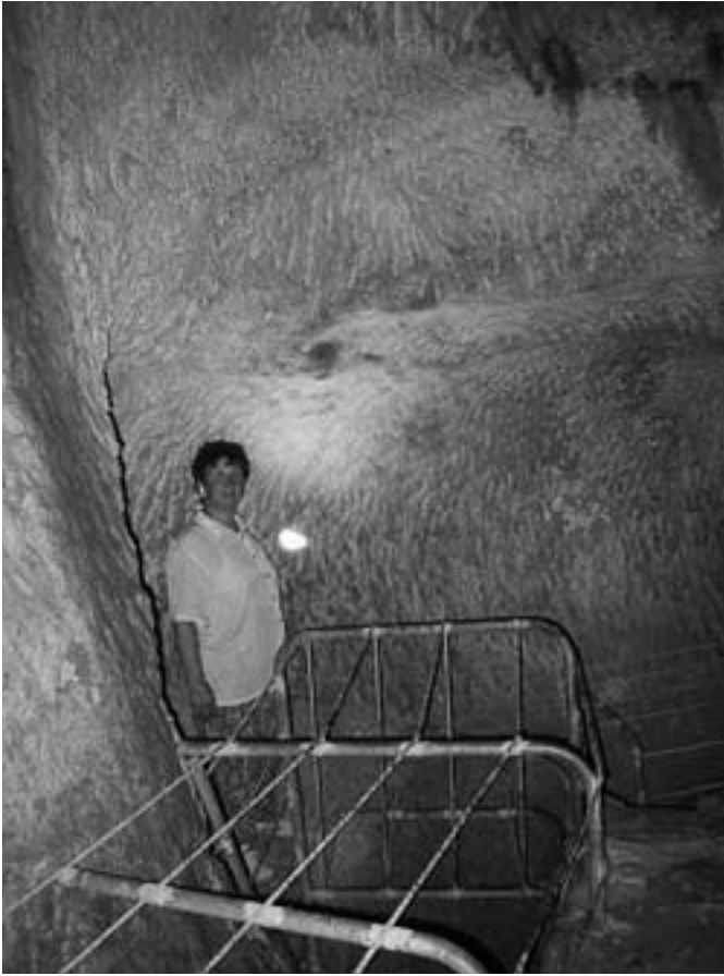
Abb. 9: Der rechtwinklige Treffpunkt. Nach rechts geht der Südstollen weiter. Deutlich sichtbar sind der vertikale Absatz von 50 cm und die Schrämmspur.
