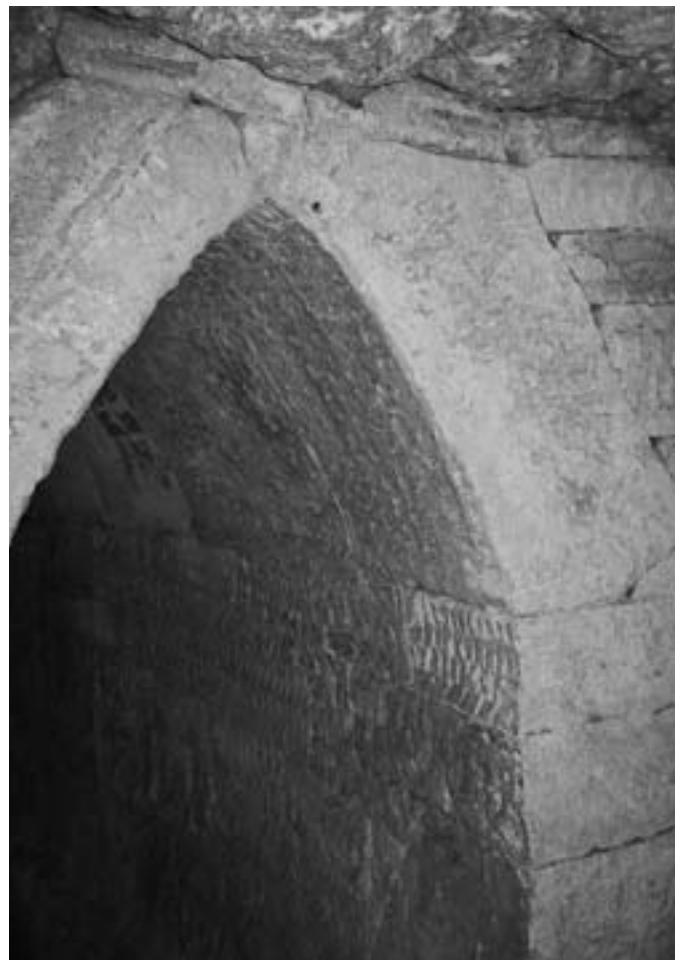
Abb. 8: Das 2500 Jahre alte Giebelgewölbe aus präzise gehauenen Steinen – unversehrt wie wenn erst gestern gebaut
