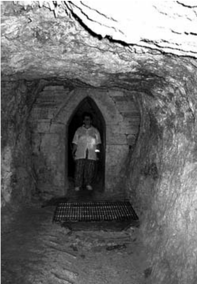
Abb. 7: Archaische Ausmauerung im nördlichen Abschnitt
