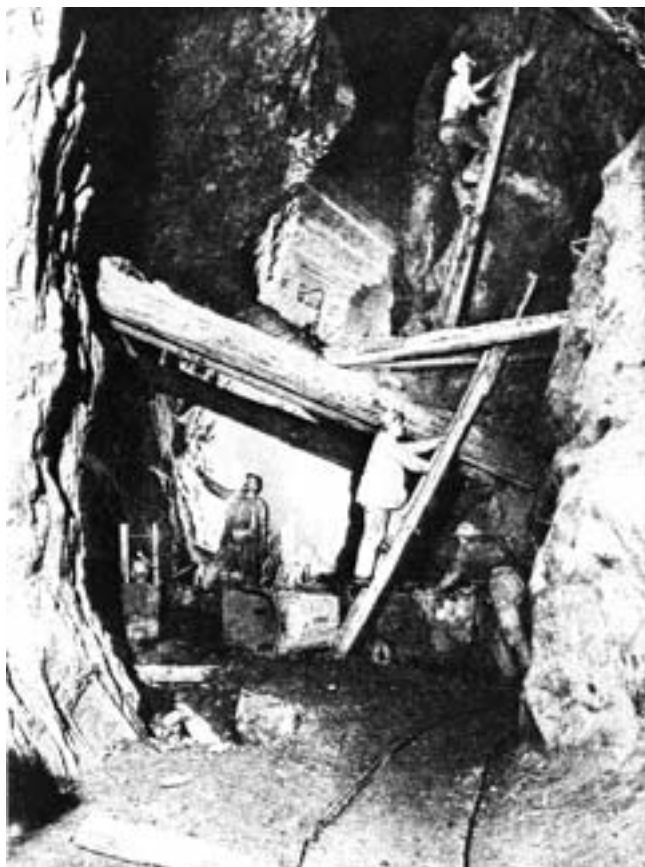
Abb. 17 Weite, nur mit Stempeln und Balkenbühnen verstrebt Gangpartie oberhalb East Pool's 330 m Sohle, um 1895. Bis 90 m oberhalb und 110 m unterhalb dieser Sohle wurde der Erzgang vollständig abgebaut, so dass riesige Höhlungen entstanden. Trotz des Einbaus von Stahlbetonpfählern und – Bögen kollabierten diese Gangpartien im Mai 1921, was zur Schliessung der Grube führte.
