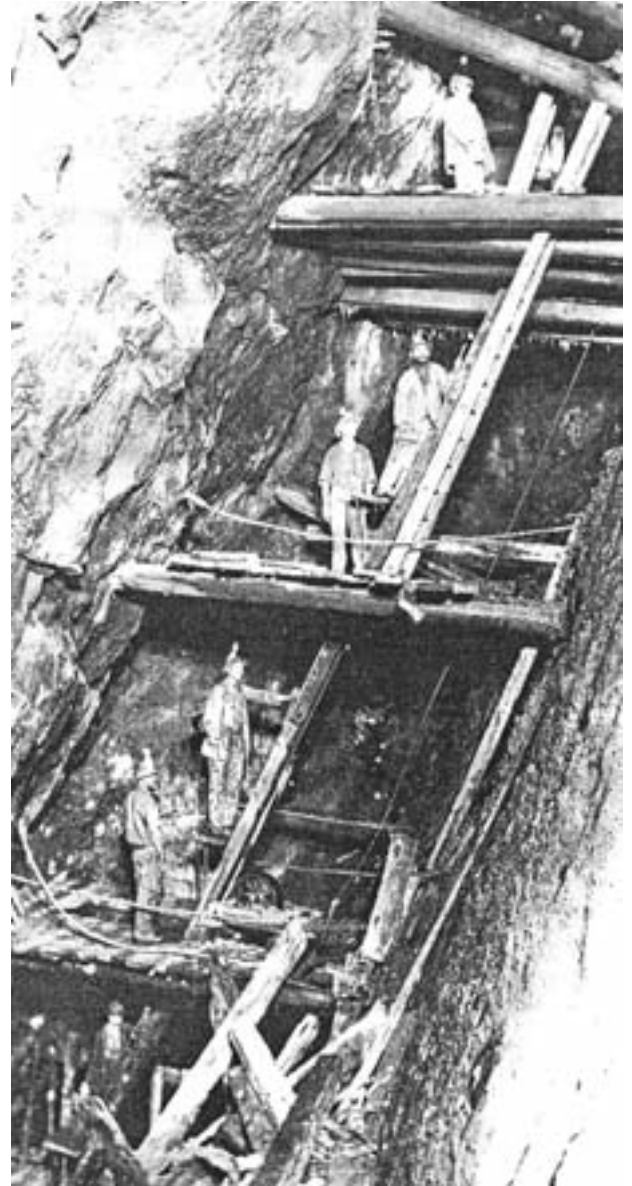
Abb. 21: Dolcoath Mine, 1892: Der berühmte Fabrikuntschacht (man engine) auf Höhe der 430 m Sohle. Zu dieser Zeit war die Fabrung bereits seit mehr als 25 Jahren in Betrieb, wobei die Verzimmerung in der feuchtwarmen Grubenluft rasch vermoderte, was häufige Reparaturen der Holzplattformen erforderte – die Balkenreste liess man im Schacht liegen (Foto J. C. Burrow, Truro Museum Coll.)
