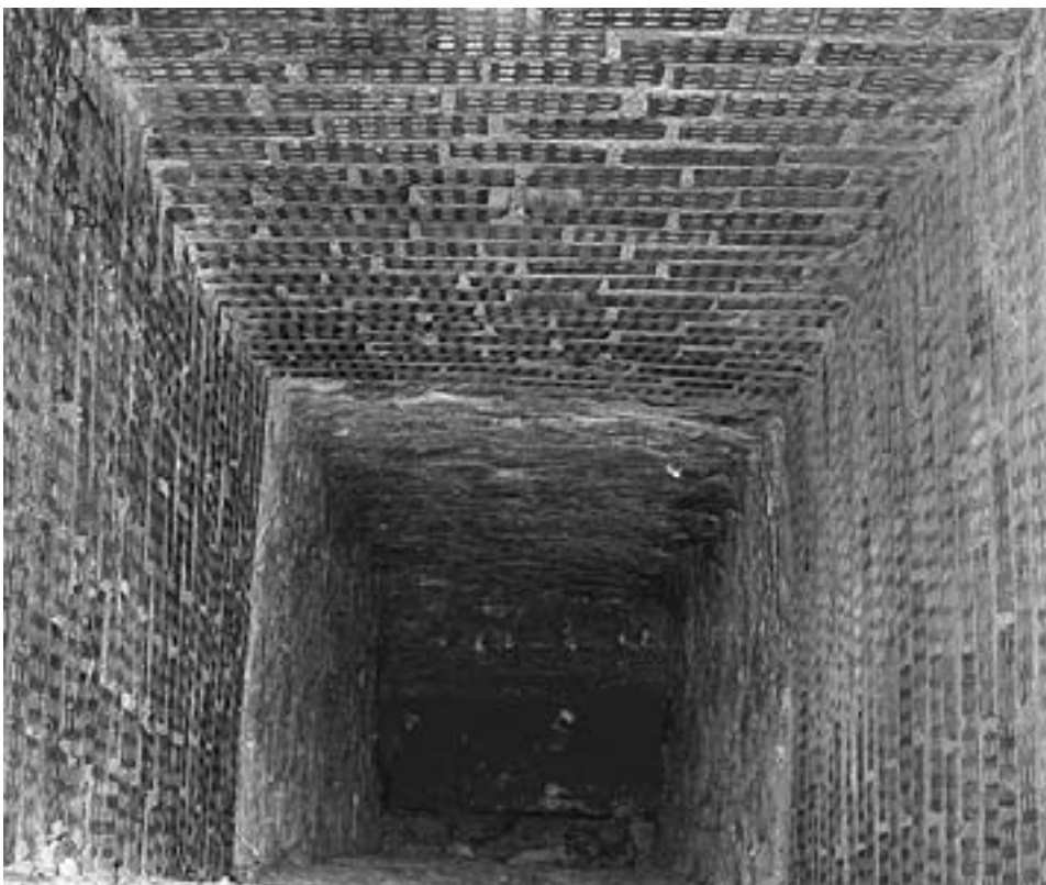
Abb. 5: Der zweitletzte Schacht: Oben mit Ziegelsteinen rekonstruiert, unten präzise in den Felsen gehauen und zuunterst der Leitungsgraben
