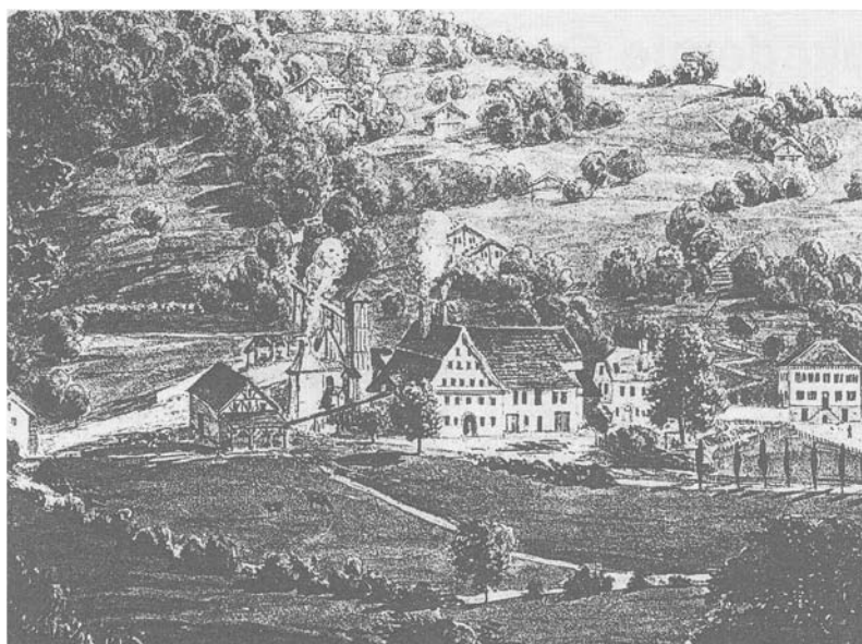
Hochofenanlage in Plons, Mitte des 19. Jahrhunderts. Im grossen Gebäude befand sich der Hochofen. Links davon die Röstanlage. Erzwäsche (etwas hinten) und die Kohlenscheune. Zwischen Scheune und Ofengebäude die Laderampe für Kohle. Hinten auf einer Holzbrücke, vom Schmelzibach her, die Wasserleitung für das Wassertrommelgebäude.
